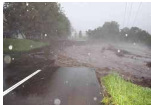
崩壊した新得小北側道路（31日撮影）
