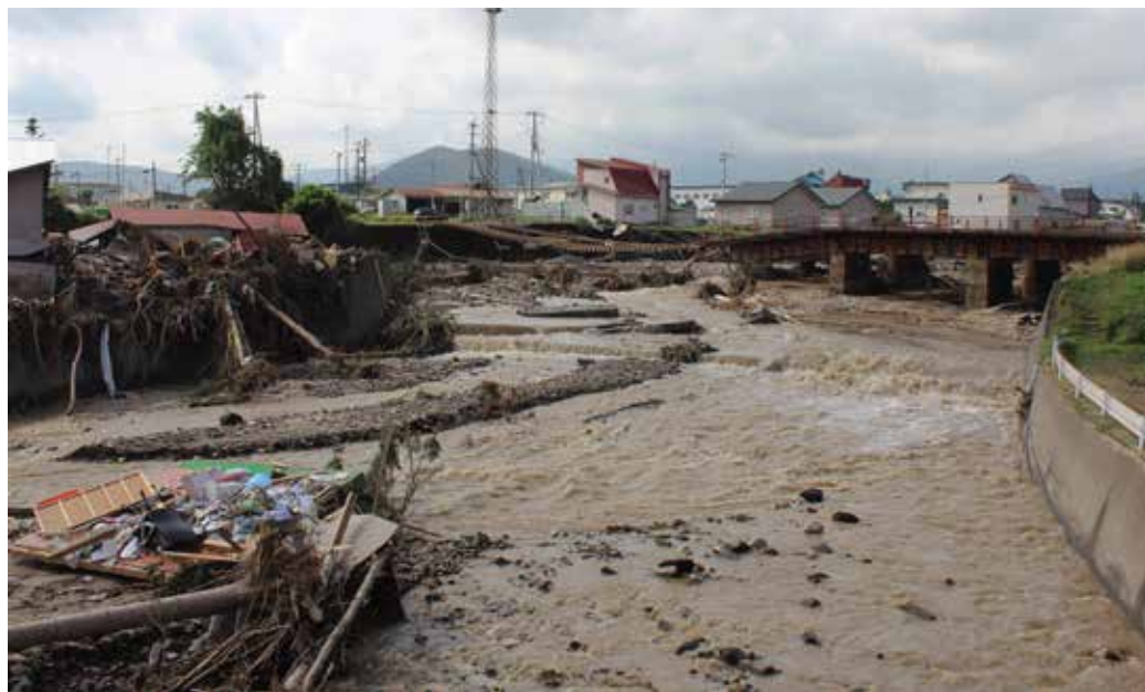
氾濫したパンケシントク川。神社橋や線路鉄橋が濁流により崩壊した（9月2日撮影）
