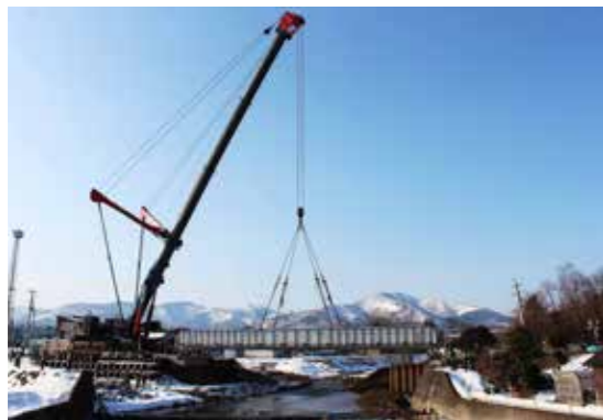
巨大な 1200t クレーンを使って鉄橋を架けた
