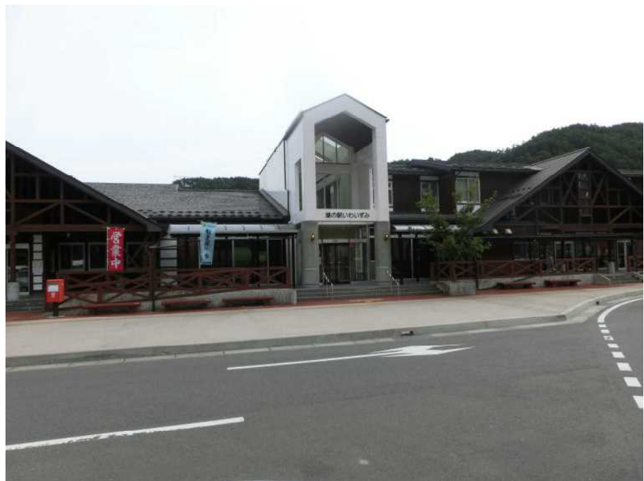
近くの河川が氾濫し、１階の窓口カウンターの高さを超える濁流がきた道の駅
