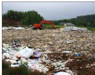
埋立処分場で埋め立て
